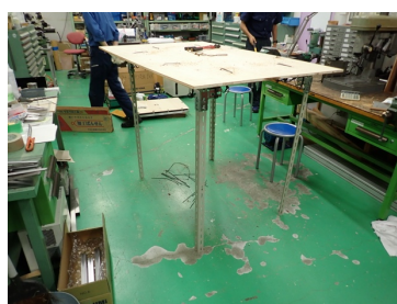
図 2 現地での作業を想定した、アングルと合板の取り付け訓練の様子。
