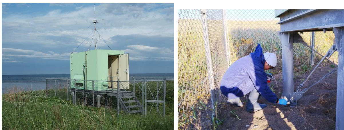
図5 オホーツク海短波海洋レーダー局。左：宗谷局、右：土台の腐食防止作業。
