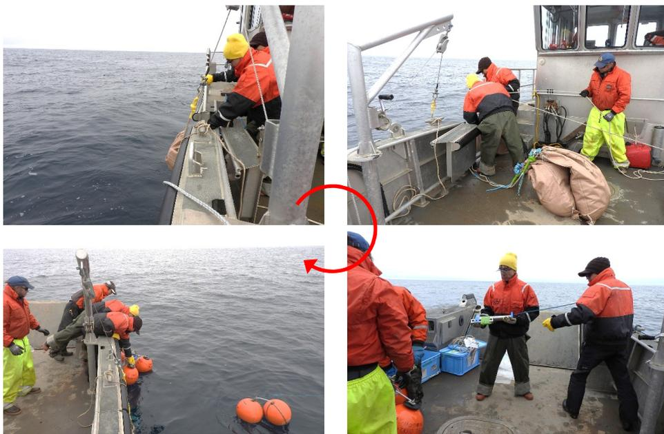
図 6 設置点 B4 における係留系再設置風景 (矢印は作業順)。
