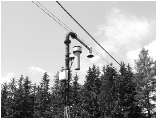
図1 老朽化した既設積雪計
