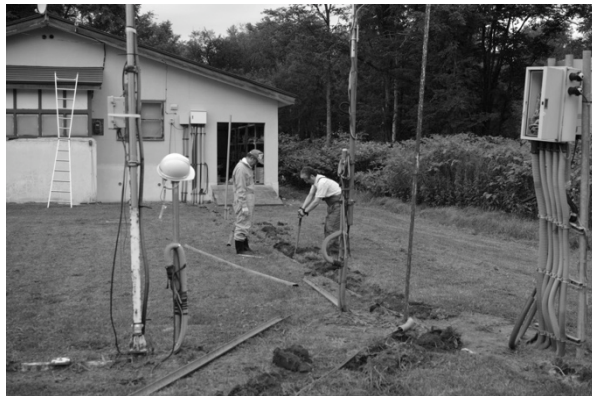
図 9 経路に沿って埋設溝の掘り起こし作業 図 10 2本のケーブルに塩ビ管を被せて敷設
