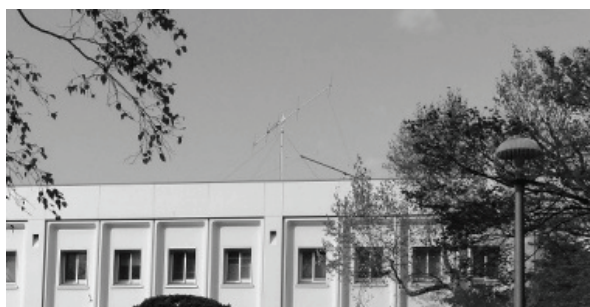
図 1 低温研屋上に設置されたアンテナ。
