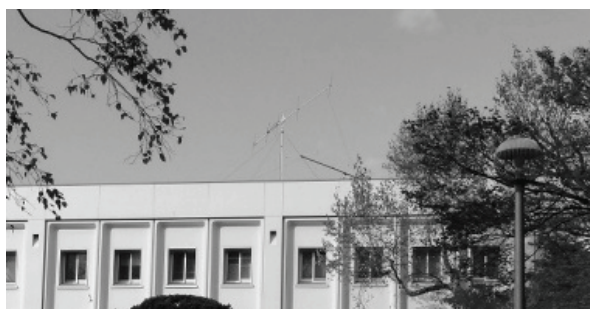
図 1 低温研屋上に設置されたアンテナ。
