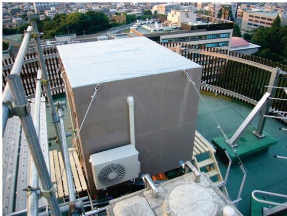
図 9 完成したシェルター。
