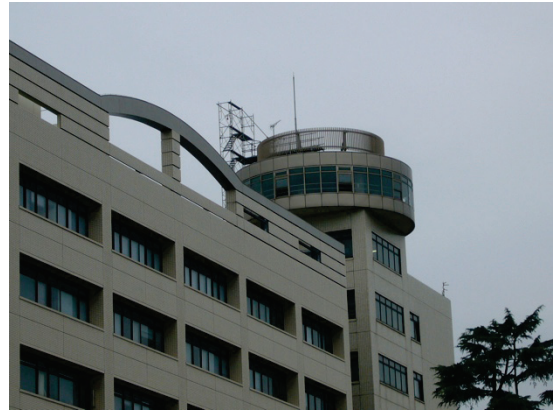
図4 ライダーを設置した屋上部。
