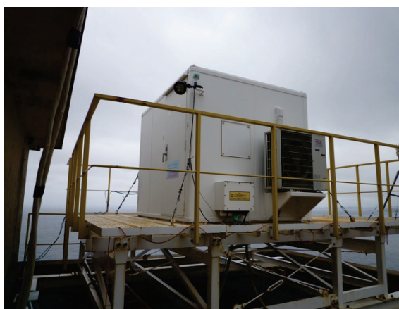
図 2 Shelter 本体（長崎県池島）。
