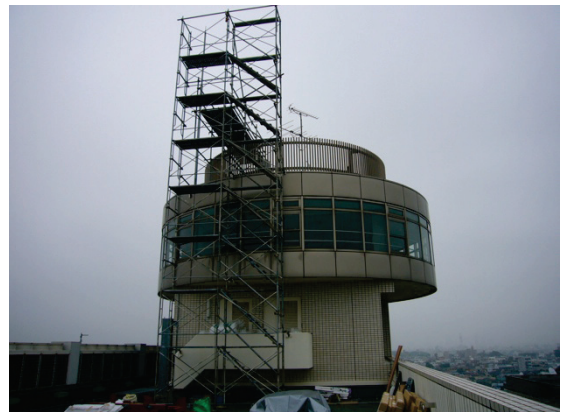
図6 展望台と仮設足場。
