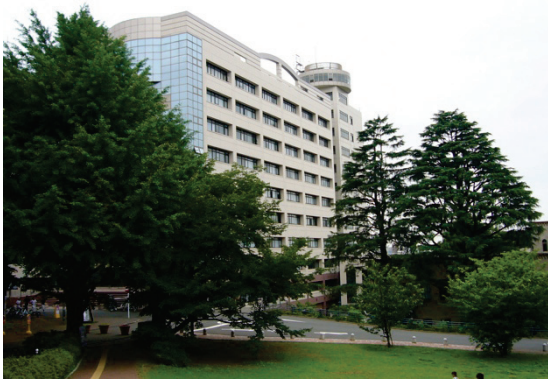
図3 東京工業大学西8号館。
