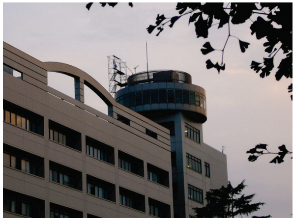
図 10 建物と同化させたシェルター。
