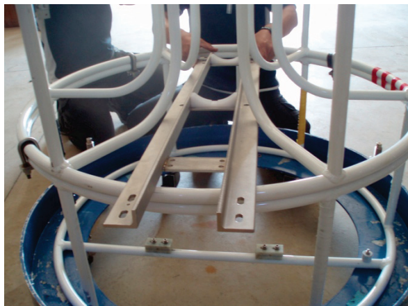
図4 既存フレームへの固定金具の取り付け。
