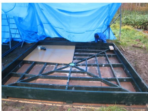
図 5：骨組みにパネコートを固定する様子
