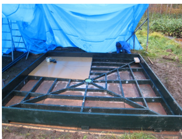
図 5：骨組みにパネコートを固定する様子
