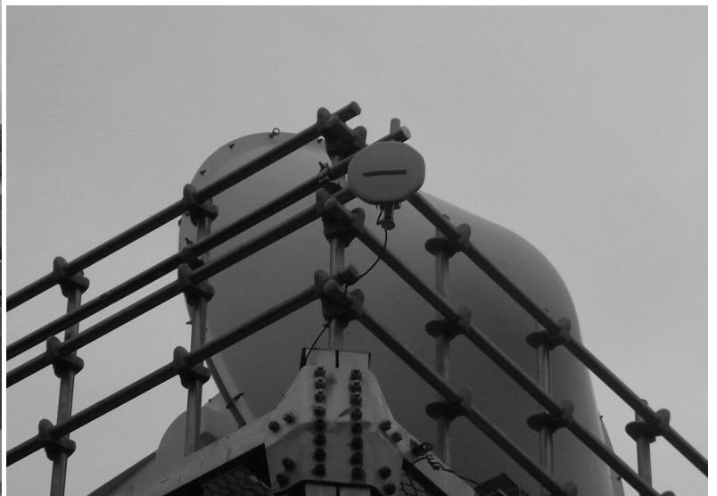
図2 設置した無線 LAN アンテナ（左：海洋交流館、右：レーダサイト）。
