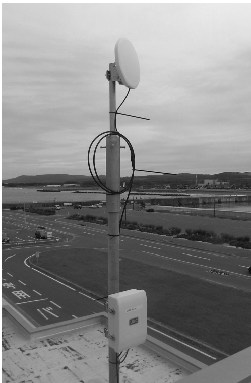
図2 設置した無線 LAN アンテナ（左：海洋交流館、右：レーダサイト）。
