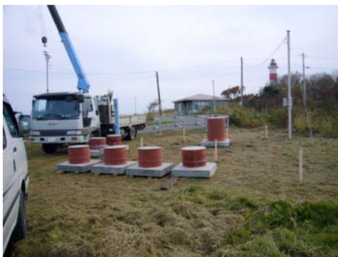
図4 ドップラーレーダーの基礎部材（左）と設置後の様子（右）
