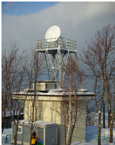
図1 紋別市大山スキー場横に設置したレーダーの外観
