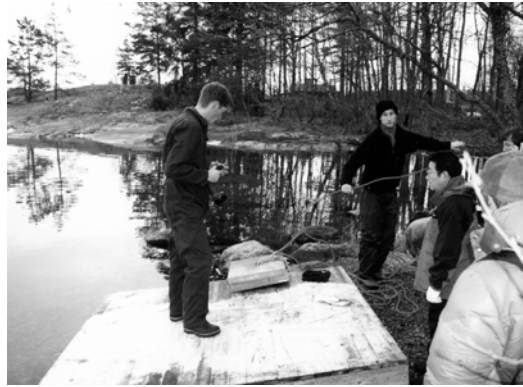
(2) アンカーの取り付け(4個)
