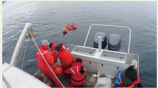
小型ボートにて、係留系設置を実施しているところ
