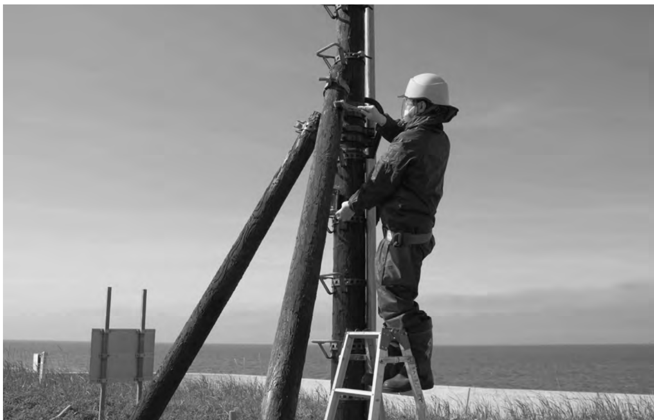
短波海洋レーダの保守（アンテナ支柱の防腐処理）
